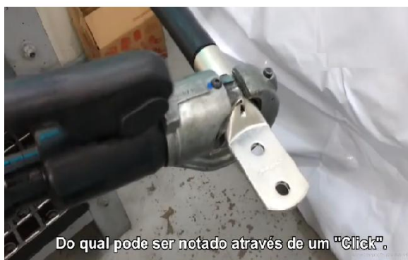
3) realização da compressão
