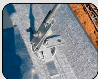
MON-3185 Fixação com minicaptor vertical
